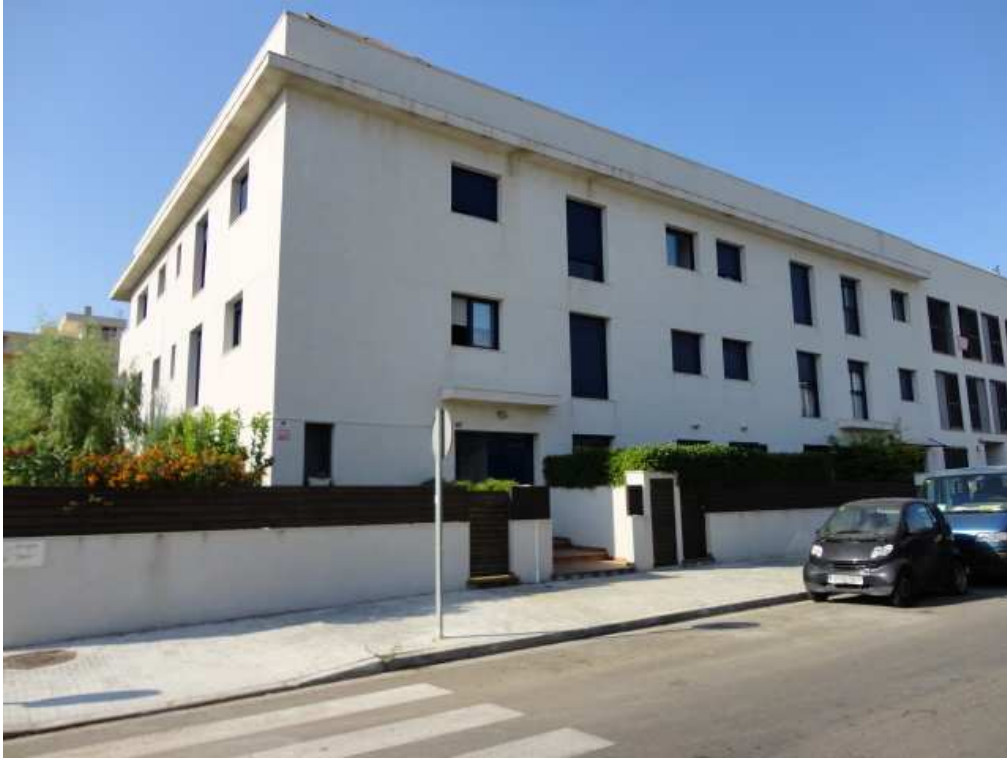
DIRECCION DE OBRA DE LA REFORMA DE CUBIERTA EN LA AVENIDA JAUME I DE CUBELLES. BARCELONA
