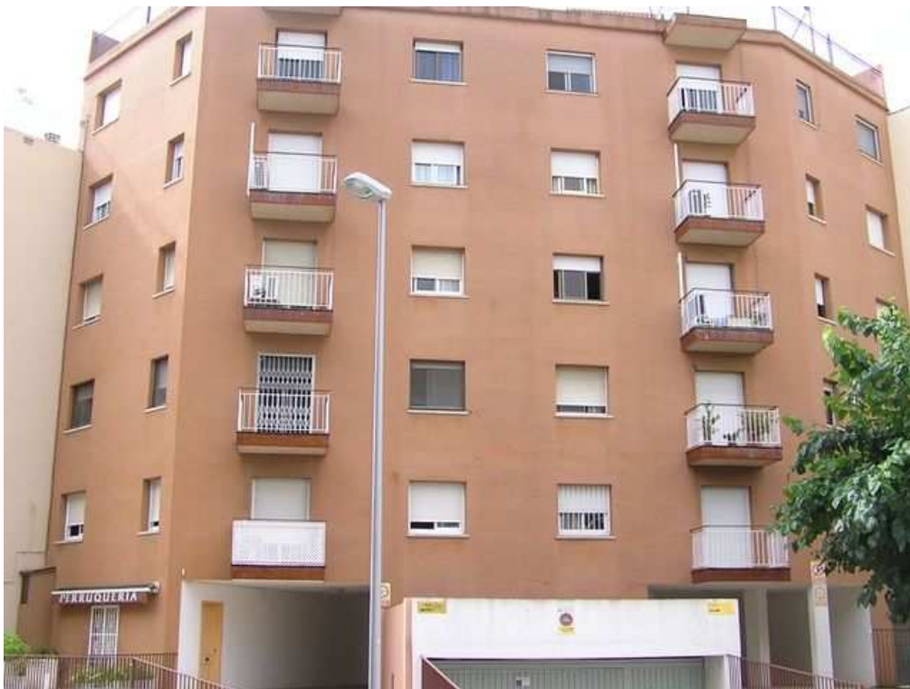
DIRECCION DE OBRA DE LA REFORMA DE FACHADA EN LA CALLE CASTELLET DE VILANOVA I LA GELTRU. BARCELONA
