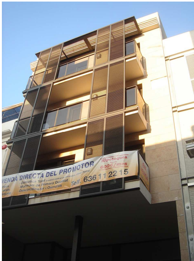
DIRECCION DE OBRA DE LA REFORMA DE FACHADA EN LA CALLE BALEARS DE VILANOVA I LA GELTRU. BARCELONA
