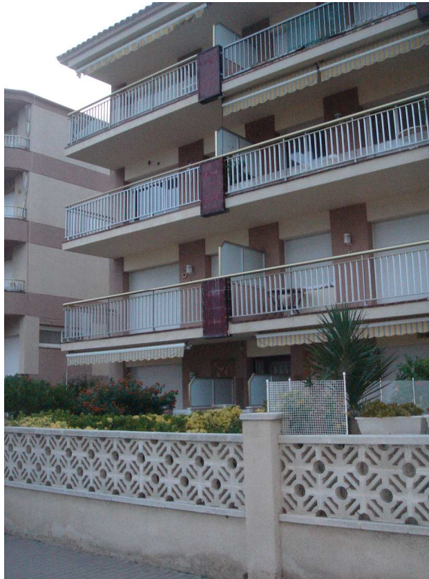
DIRECCION DE OBRA DE LA REFORMA DE FACHADA EN LA CALLE VORAMAR DE VILANOVA I LA GELTRU. BARCELONA
